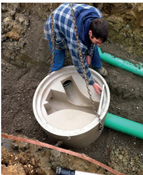
1. Schachtboden setzen
