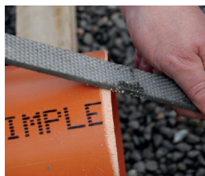
7. Anschleifen des Kunststoffrohrs
