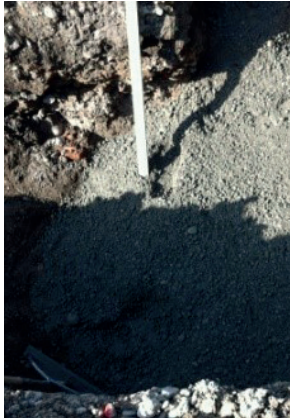
1. Vorbereiten der Grubensohle
