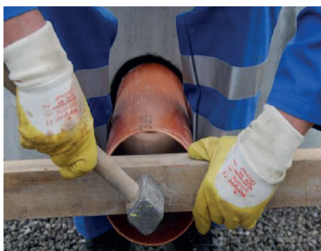
10. Zentriertes Ansetzen des Kunststoffrohrs. Dichten des Kunststoffrohrs je nach Witterung (Temperatur) mit einem kräftigen Hieb.
