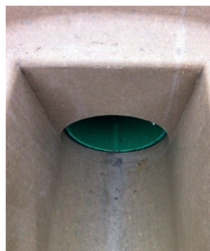
11. Optimaler Muffen spalt nach dem Einschub und Richten des Kunststoffrohrs
