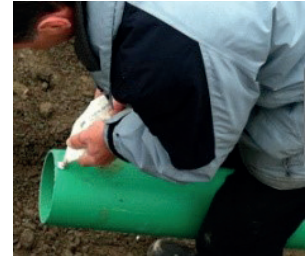
9. Aufbringen von geeignetem Gleitmittel auf dem Anschlussrohr
