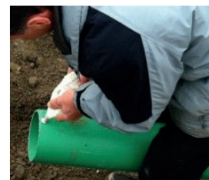
9. Aufbringen von geeignetem Gleitmittel auf dem Anschlussrohr
