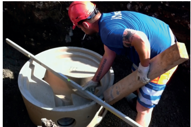
3. Kontrolle der Lage des Schachtbodens
