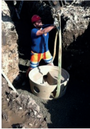
2. Versetzen Schachtboden auf horizontale Betonsohle
