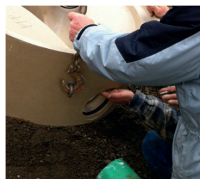
8. Aufbringen vom geeigneten Gleitmittel auf den Dichtungsring
