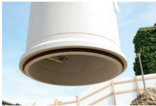
2. Kontrolle Dichtung
