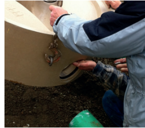
8. Aufbringen vom geeigneten Gleitmittel auf den Dichtungsring
