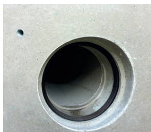
6. Muffendetail für Rohranschluss
