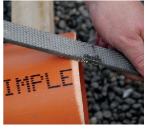
7. Anschleifen des Kunststoffrohres
