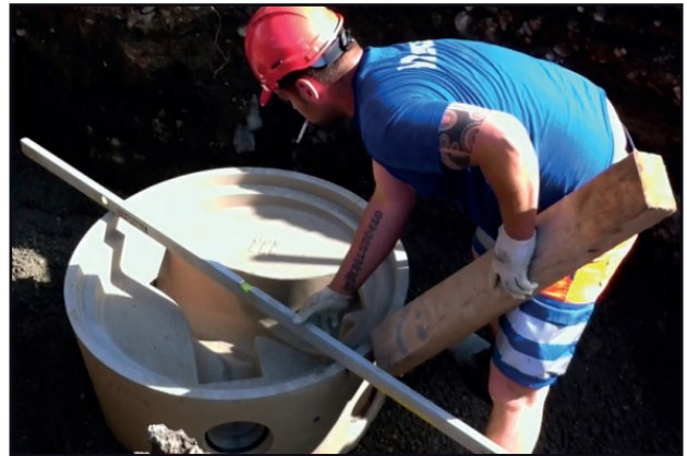
3. Kontrolle der Lage des Schachtbodens
