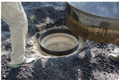
Schachtkopf freilegen, Stahlplatte entfernen, Adapterring versetzen
