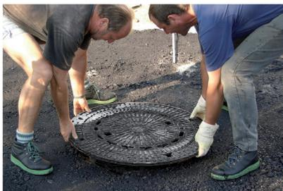
Komplette Schachtabdeckung einsetzen
