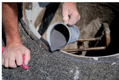
Fuge zwischen Rahmen und Deckbelag fertigstellen
