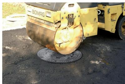
Schachtabdeckung oberflächenbündig einwalzen
