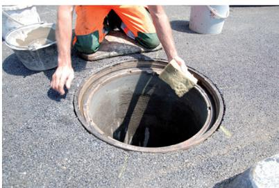
Schalung entfernen, reinigen
