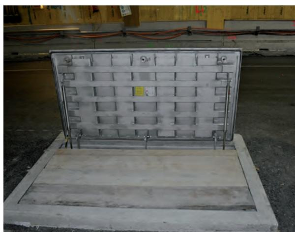
Grosse, schwere oder häufig zu öffnende Abdeckungen können mit Öffnungshilfen ausgestattet werden und ermöglichen dadurch eine einfache und schnelle Bedienung. Einsatzbereich: von begehbar bis für den Schwerlastverkehr.
