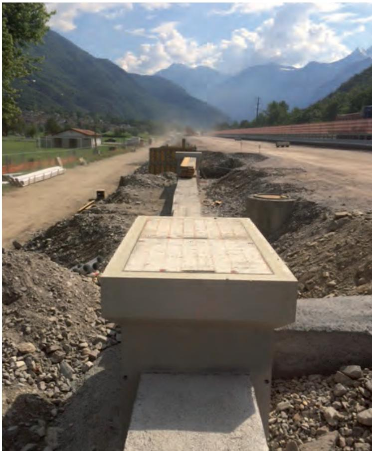
Neubau der Kabelanlagen entlang einer Autobahn. ACO Kabelzugschächte werden je Bauabschnitt versetzfertig geliefert.
