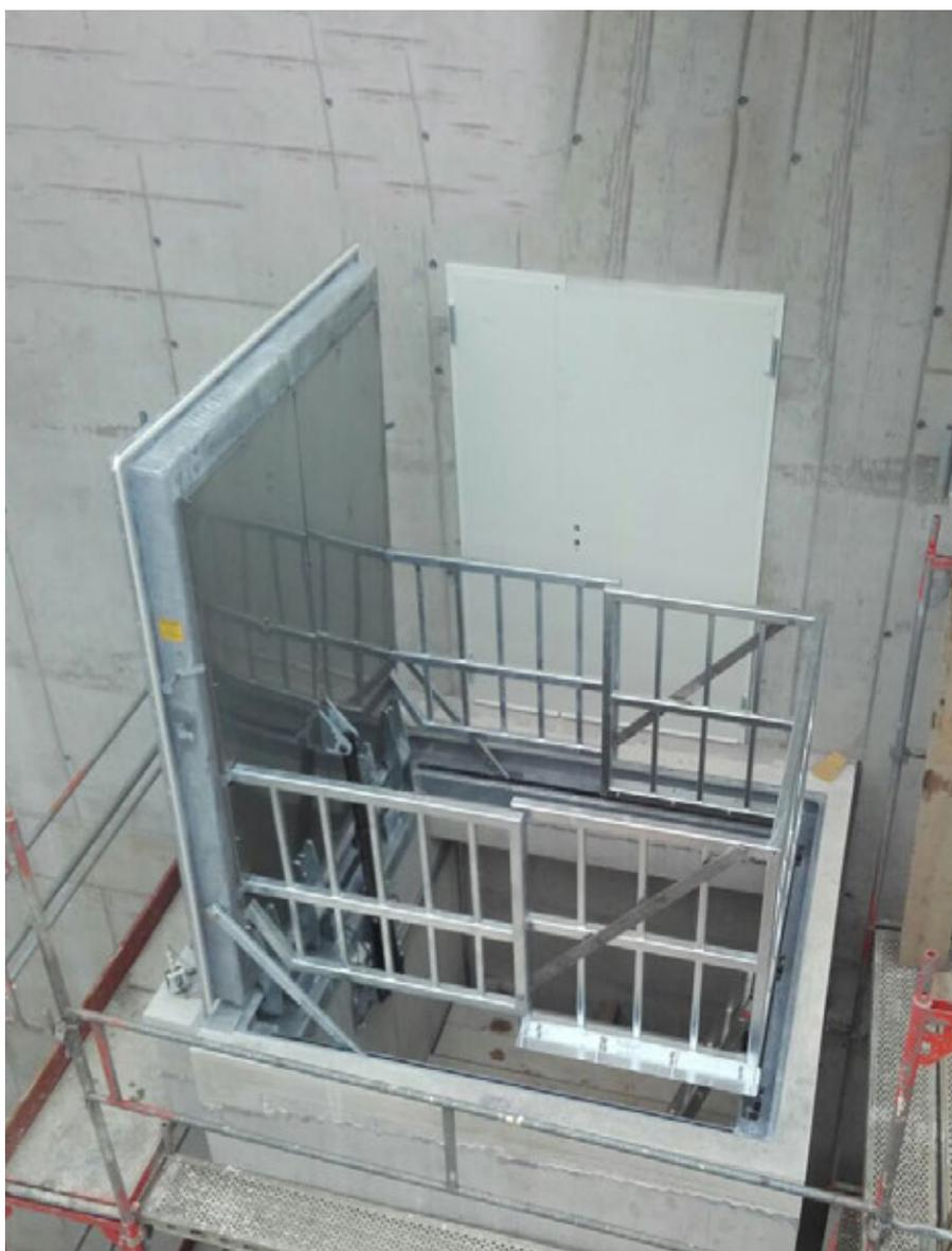
RWA-Entrauchungsklappe mit automatischer Öffnung
