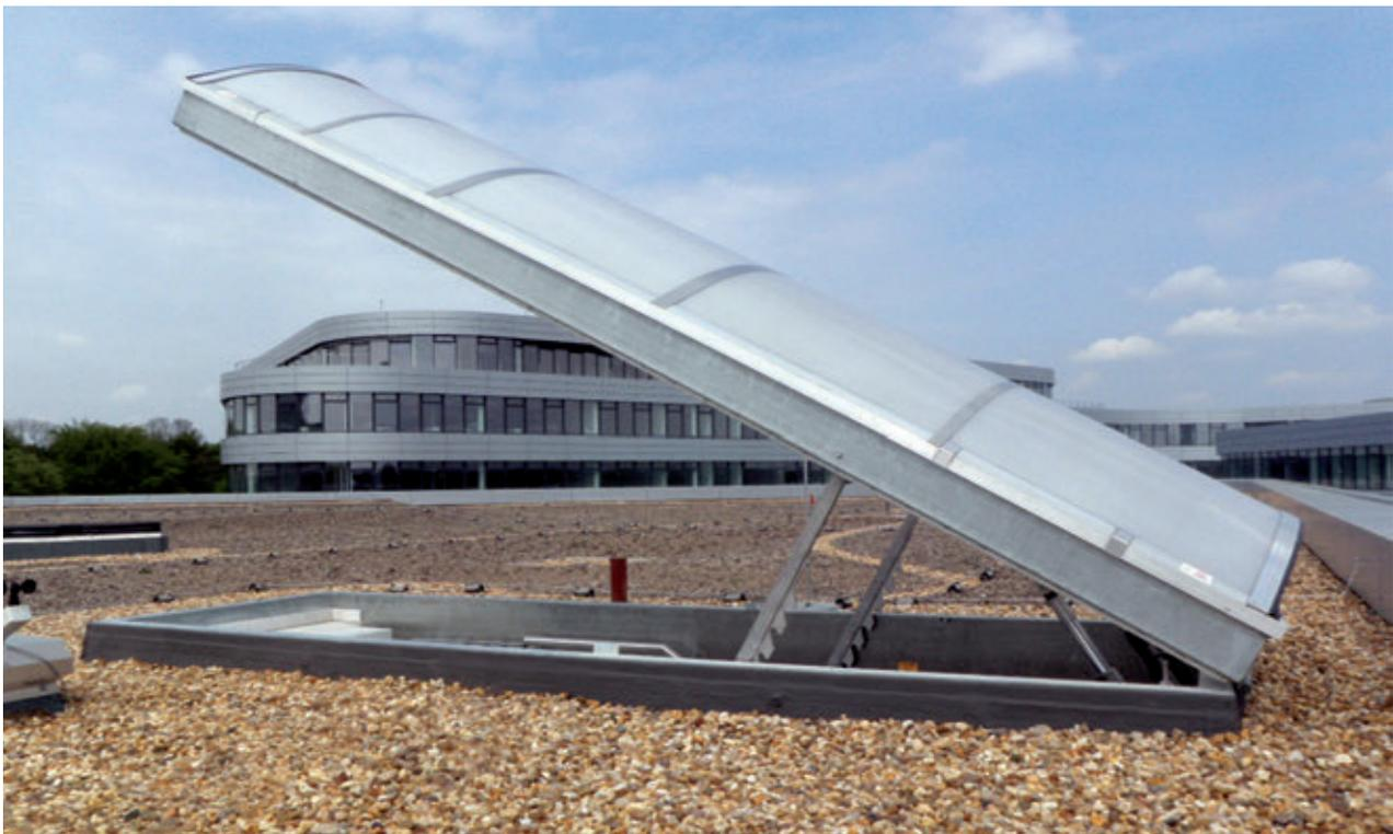
Hydraulisch betriebener Dachausgang und RWA-Klappe
