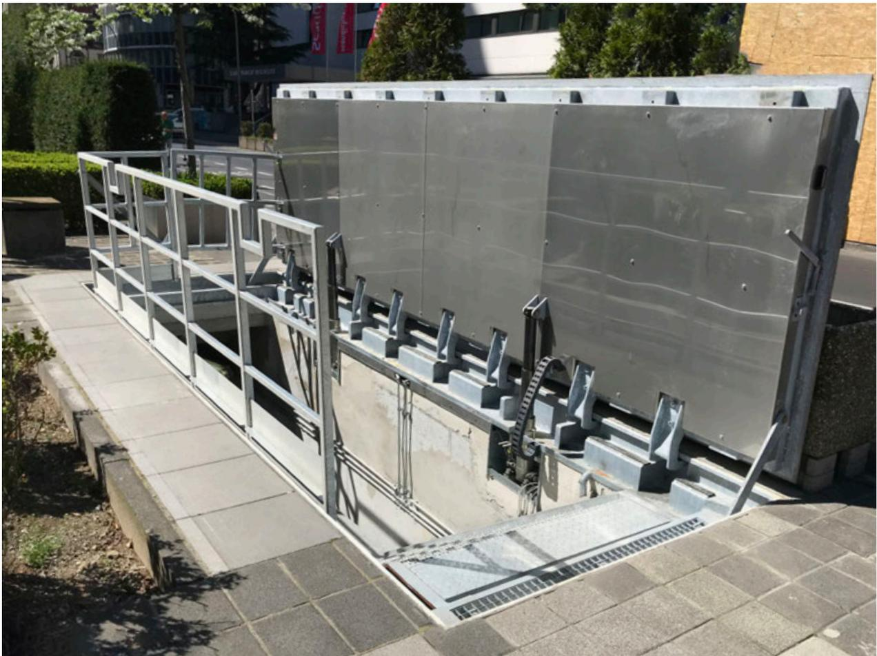
Treppenausstieg mit Brandschutzplatten und Schutzblech
