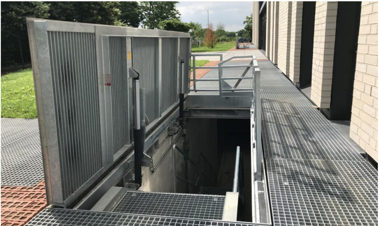
Bodentor mit integriertem Klappgeländer
