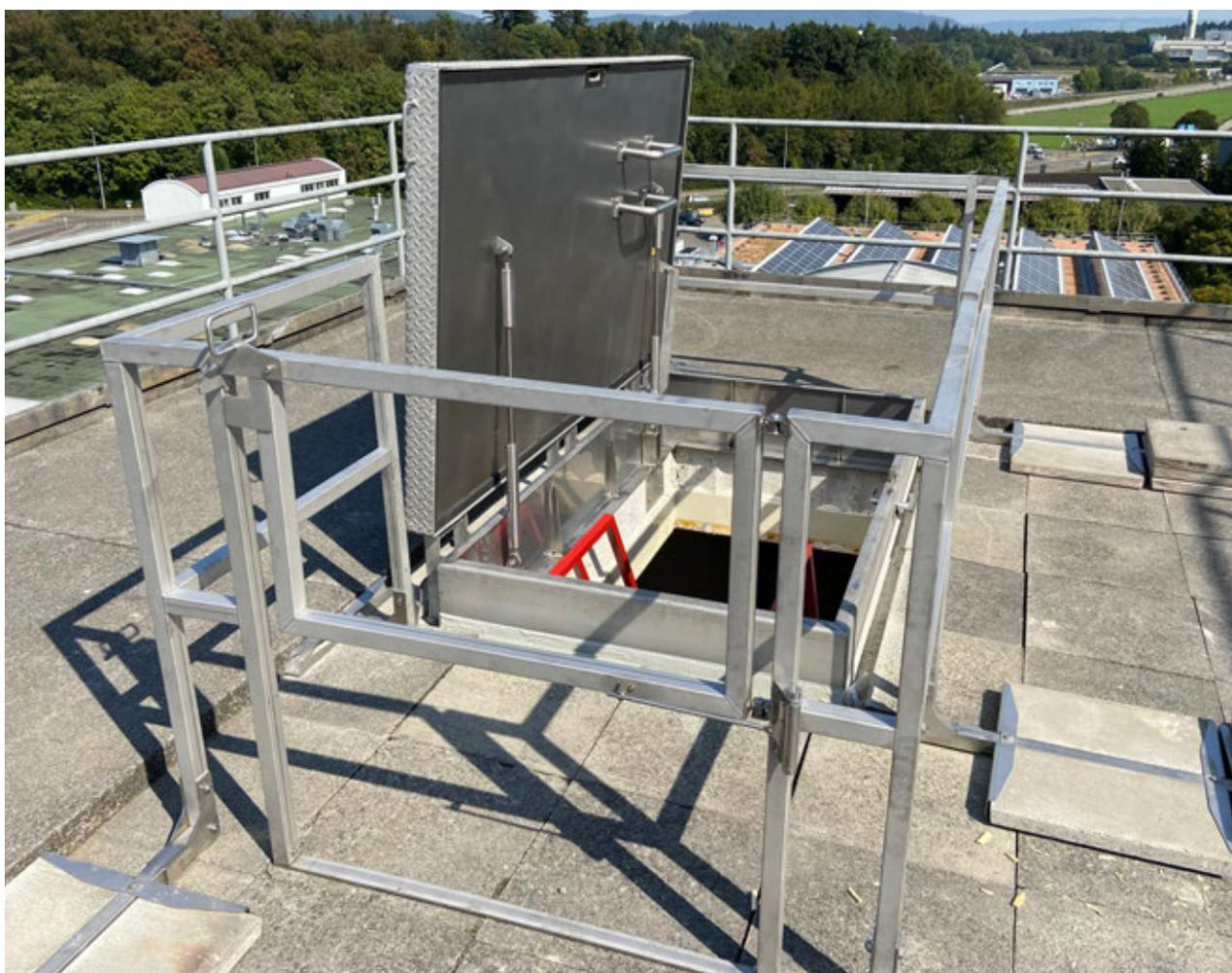
Notausstieg auf Bauwerk aufgesetzt, mit Geländer
