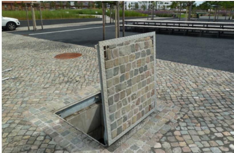
Abdeckung mit auspflasterbarer Oberfläche Klasse D 400
