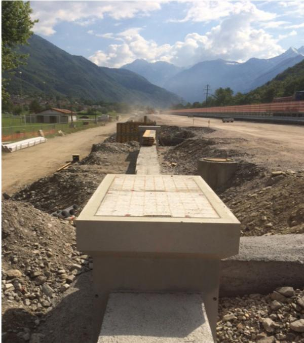
Kabelzugschacht für den Nationalstrassenbau
