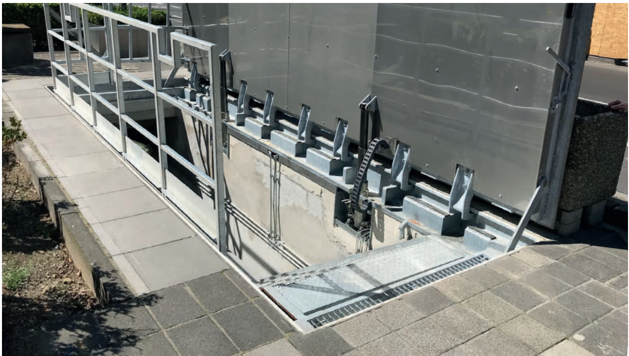
Treppenausstieg mit Brandschutzplatten und Schutzblech
