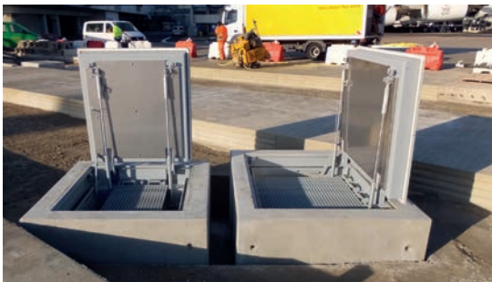
RWA-Entrauchungsklappe mit Öffnungshilfe
