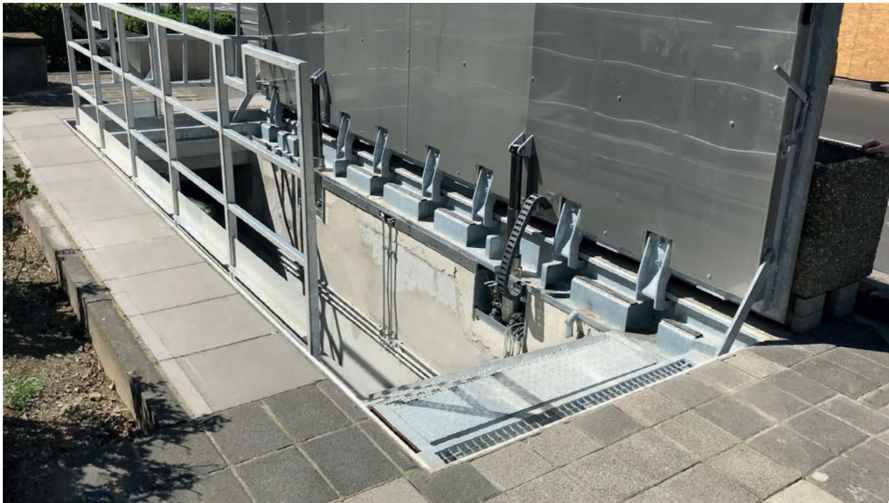
Treppenausstieg mit Brandschutzplatten und Schutzblech
