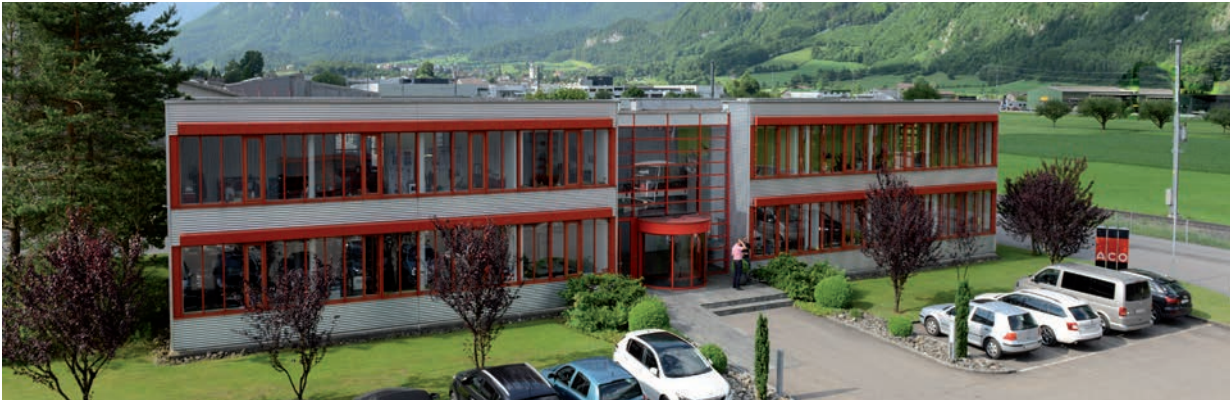
ACO Passavant AG, qui s'est installée en Suisse depuis 1972, est aujourd'hui présente dans trois sites avec 140 collaborateurs.
