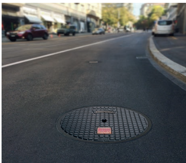
Fonte de voirie
