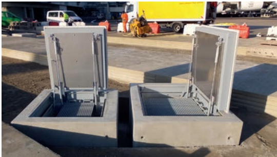
Volet de désenfumage EFC avec ouverture assistée
