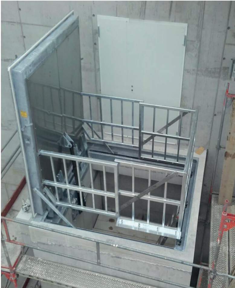
Volet de désenfumage EFC à ouverture automatique
