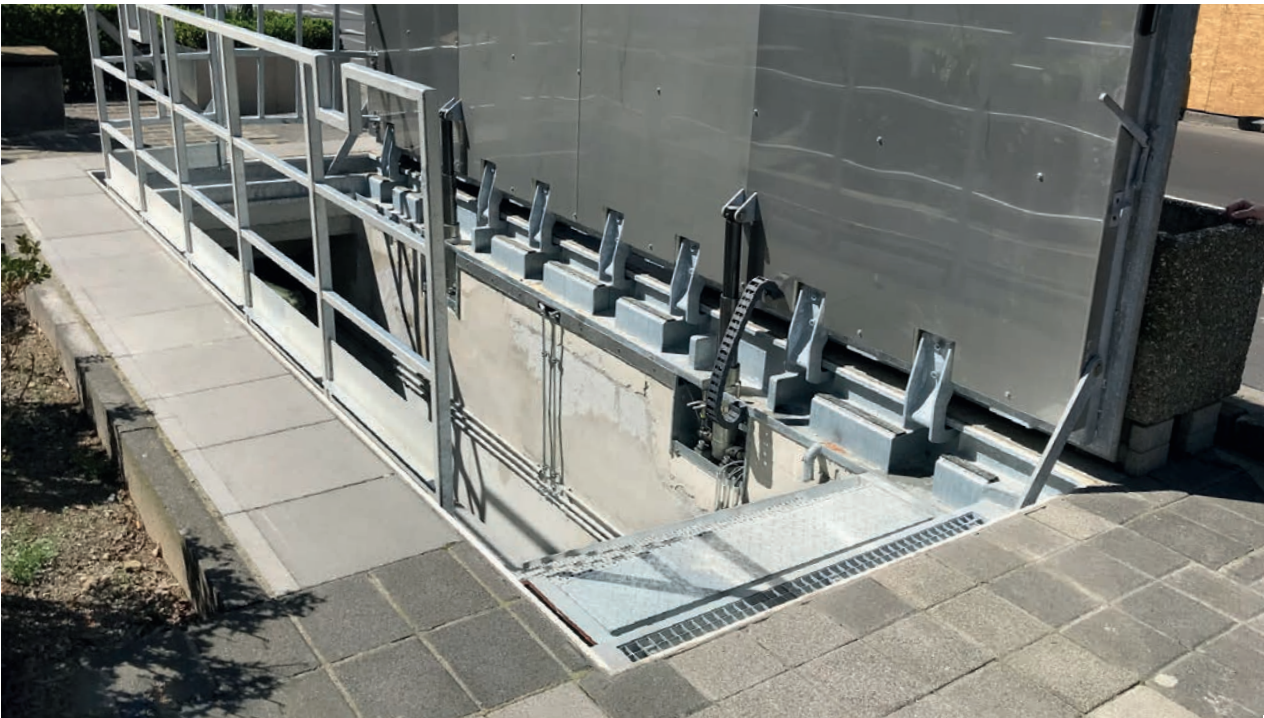
Sortie d'escaliers avec panneaux coupe-feu et tôle de protection
