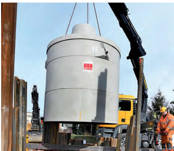
Pozzetti e fondo del pozzi
